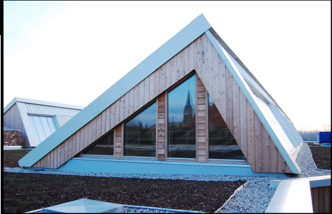
TOITURE ET PIGNONS APRÈS TRAVAUX
