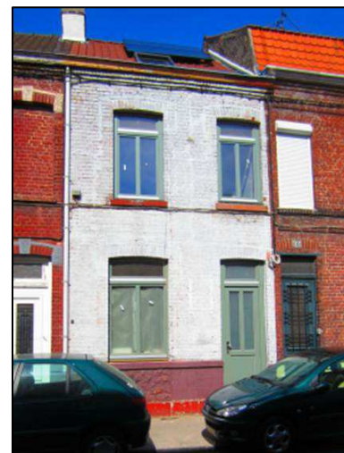
← Façade Sud sur rue
