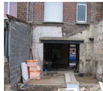
DÉMOLITION AVANT TRAVAUX
