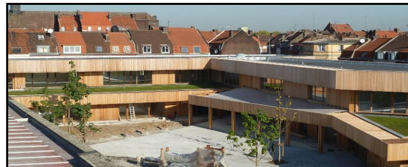
L'école avant et après sa réhabilitation
